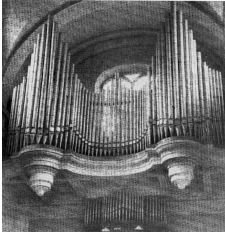
Orgue de l'église Toussaint de Rennes (la tuyauterie est posée sur une dalle en béton, le petit orgue que nous apercevons en dessous est une simple façade qui cache la machine pneumatique). (photo X..., Coll. Inventaire orgues Ille-et-Vilaine)
